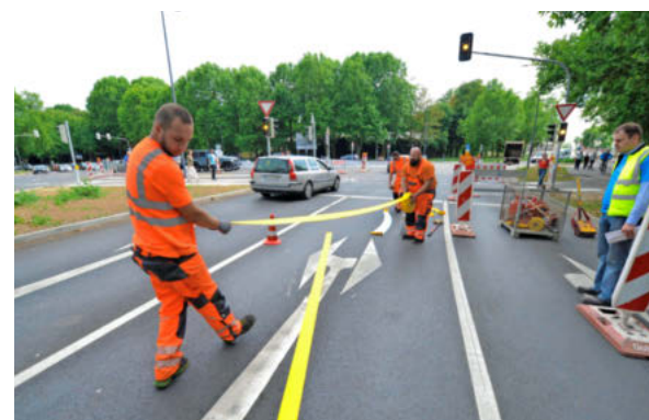
Straßenspernung am Europaplatz. Die Bleichseebrücke und die Kranen- und Kalistraße sind dicht.
